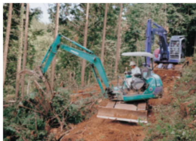
機械化でスピードアップした作業路開設
